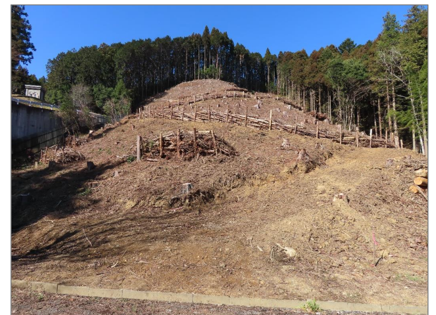
③ 対象地(全景・現況) 2021年3月撮影
