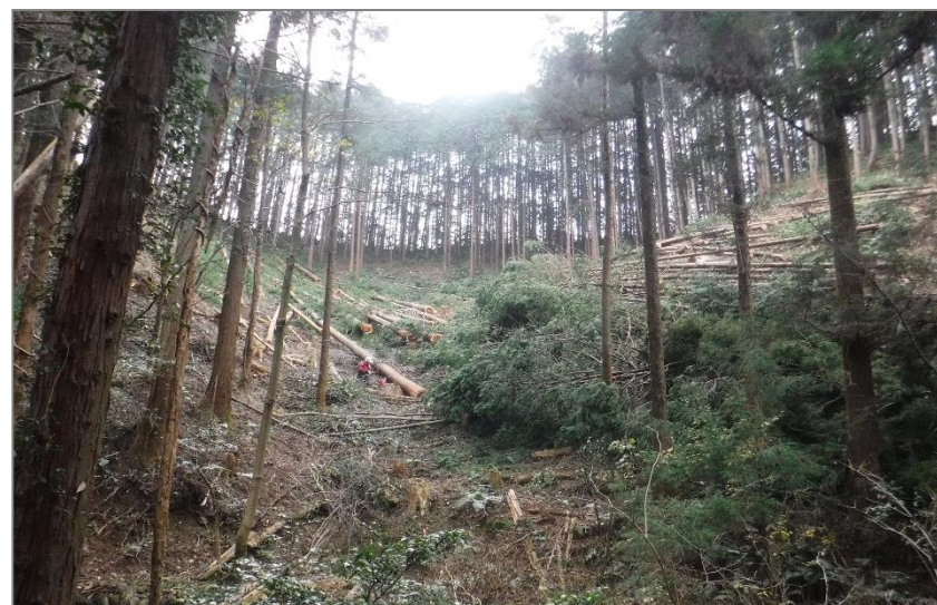
② 伐採搬出中 H27年12月撮影
