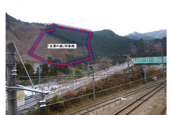
④御嶽駅から対象地を望む
