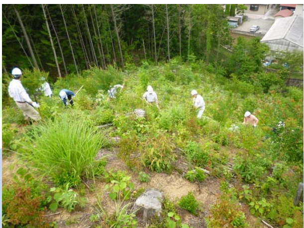
斜面の下から上に向かって作業
