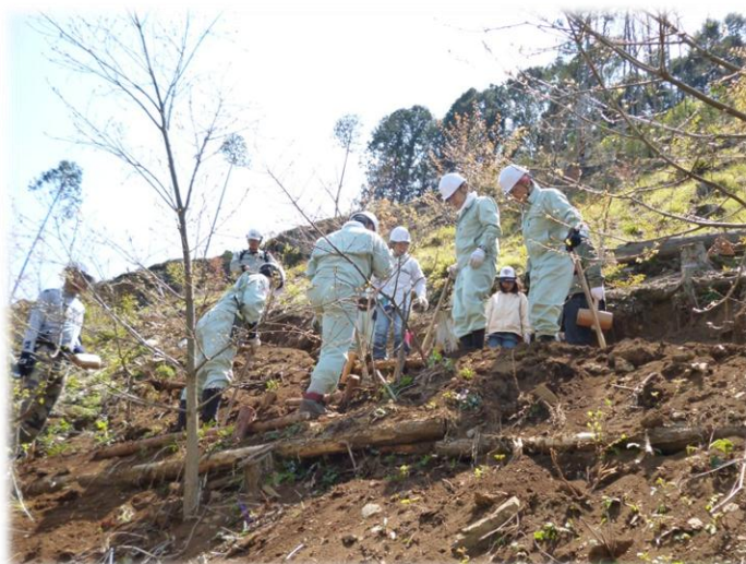
斜面にて階段を補修
