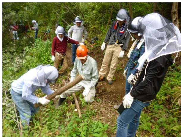
切断した倒木の幹を使って歩道の土留めを行う
