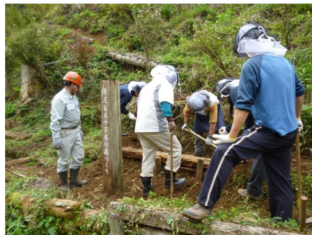
倒れた標柱を建て直す
