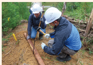
丸太で路肩を補強
