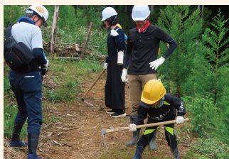
歩道をならして補修
