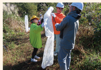
単木保護ネット設置作業
