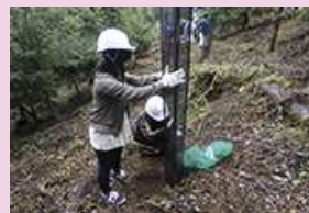
シカ害防止ネット設置
