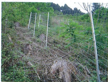
急斜面版 シカ侵入防止柵 設置状況
