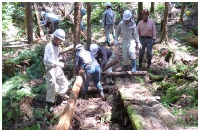
橋の架け替え作業
