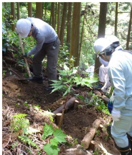
急勾配の箇所への階段設置
